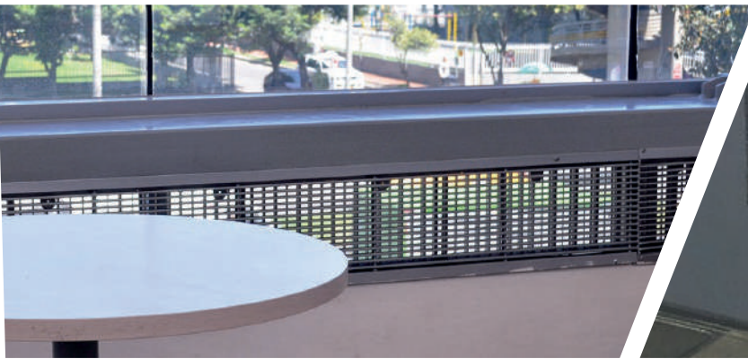
Rejillas ventilación interna
